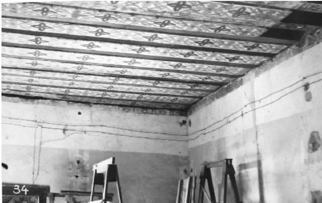
Figura 49 – Forro à têmpera. Sala da Sacristia, 1958.
