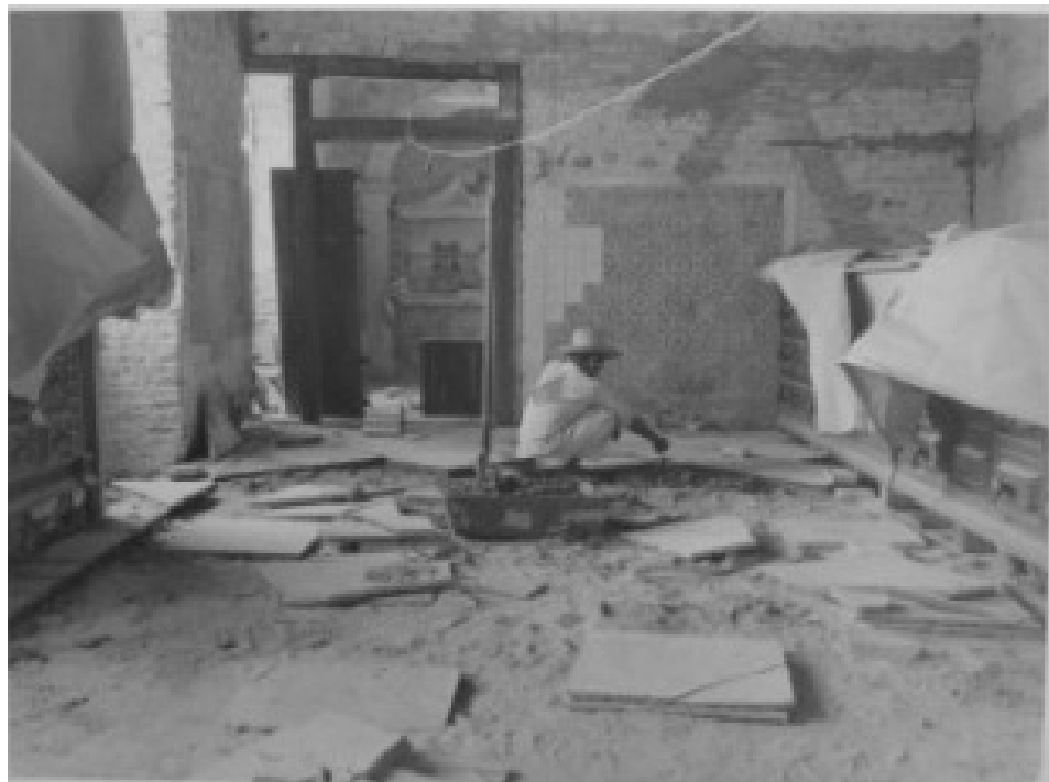
Figura 42 – Assentamento de piso na Sacristia, 1959.
